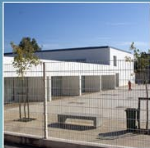
Escola da Ermida / Dono Obra: C.M. Matosinhos / Proj.: Eng.º Álvaro Correia Pinto / Empreiteiro: M&S - Construtora, SA / Vão Máx.: 13,60 m
