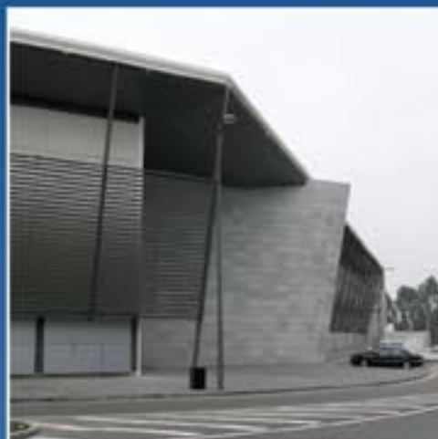
Edifício Sede da deBorla / Empreiteira: Beirãomega, Lda. Área aproximada: 2000 m 2
